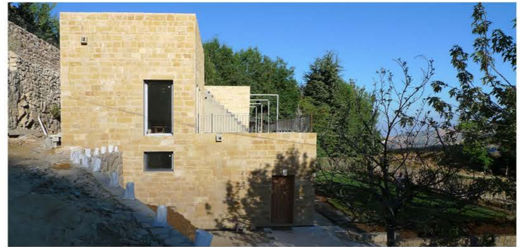
Photo de la façade est
