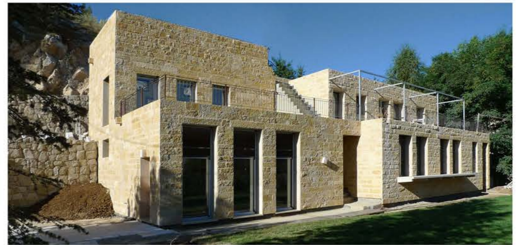
Photo de la façade nord
