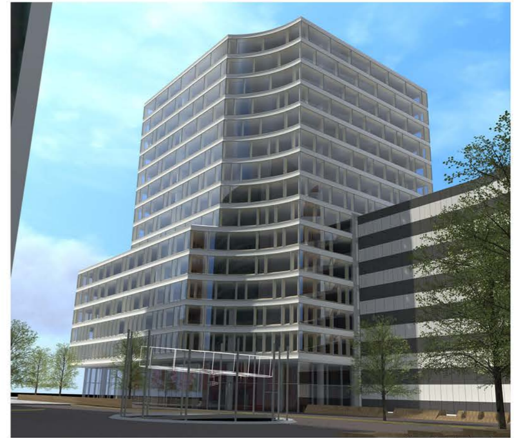
Vue générale du sud-est
