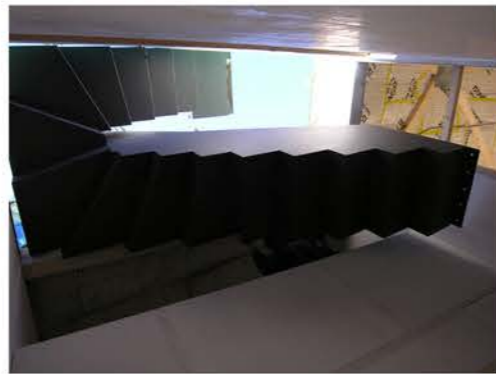
Installation de l'escalier entre le rez et le premier étage
